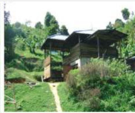
รูปที่ 3.2 บ้านเรือนที่ตั้งอยู่ใกล้ดินถล่มในเขตพื้นที่ 3 บ้านดินแดง ตั้งอยู่บนพื้นที่ลาดชัน ซึ่งดินร่วนและมีร่องรอยดินถล่มในอดีต
